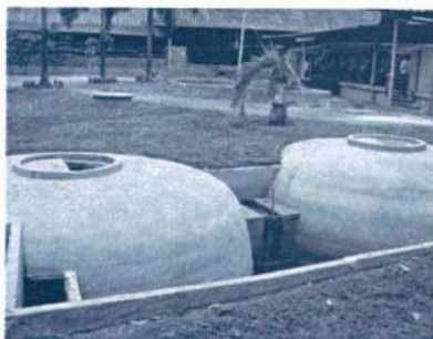
รูปที่ 9 ตัวอย่างบ่อโดมคงที่ (Fixed Dome)
