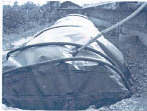
รูปที่ 8 ตัวอย่างบ่อก๊าซชีวภาพสำเร็จรูปขนาดเล็ก (Package Biogas)
